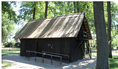
Der Treppenspeicher Lutterloh in neuem Glanz
