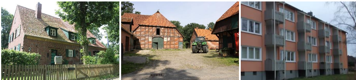
Abb. 8: Typische Wohnformen und Siedlungsstrukturen im Oberen Örtzetal
